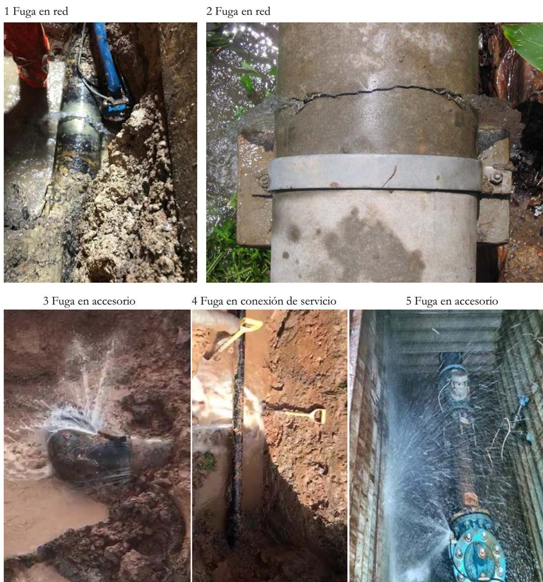
**Figura 26** Fugas típicas (Fuentes: Severn Trent Water (1, 3, 4, 5), Atkinson (2)).
